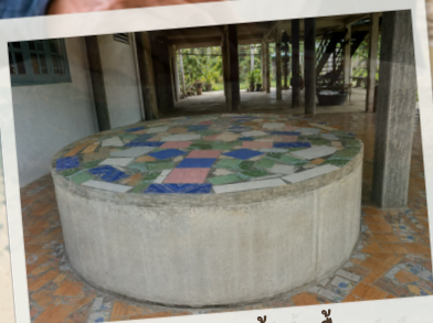
บ่อก่อสร้างแบบตึงบอนพื้น ครัวเรือน
